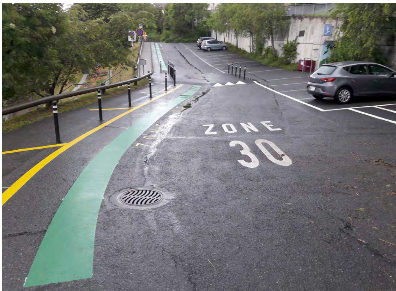
Suite au Plan de mobilité scolaire, la commune de Montreux a réaménagé la zone de dépose-minute proche de l'école de Chernet. Située sur un parking existant, elle permet aux véhicules de s'arrêter le long de la bande verte. L'espace de dépose ou d'attente pour les enfants est protégé par les potelets.
